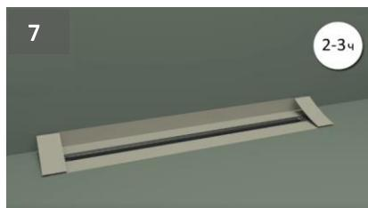
Заклейте края карьера решетки до внутреннего периметра карьера гидроизоляционной лентой MAPEI, входящей в комплект.
