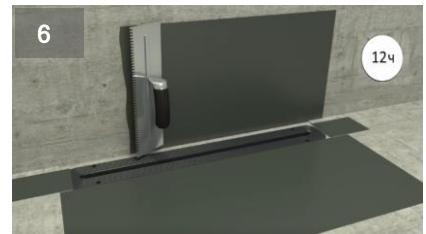
Нанесите первый слой гидроизоляционного поверхностного герметика до уровня карьера решетки.
