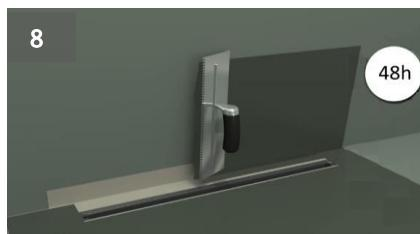
Нанесите второй слой гидроизоляционного поверхностного герметика.
